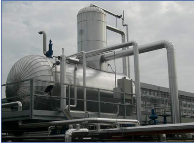
Fig. 31 - Degasatore pressurizzato
